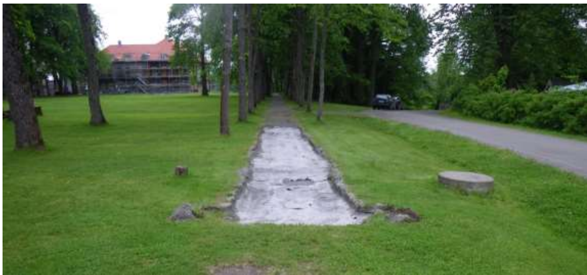
Figur 95. Østre alléns södra del fotograferad mot norr efter att det moderna gruset tagits bort och den underliggande markduken blivit synlig. Foto: 120612AA.
