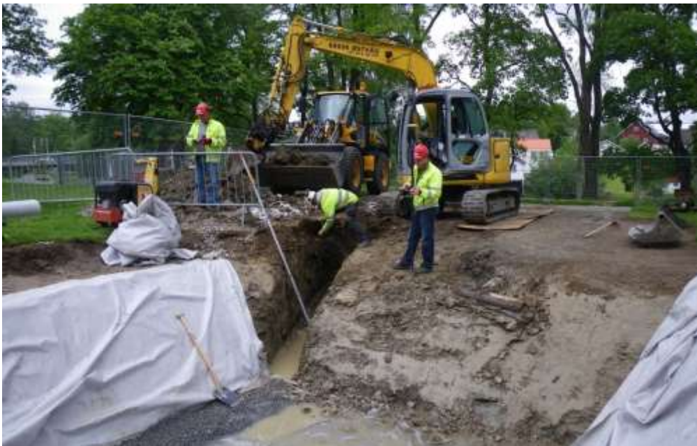
Figur 36. På västsidan om gången norr om Ankermonumentet grävdes ett smalt schakt för en dränering av Ankermonumentets grundläggning. I schaktet framkom trästockar (Tre C & D) och en möjlig syllsten (Stein C).Fotografiet taget mot norr. Foto: 120613AA.
