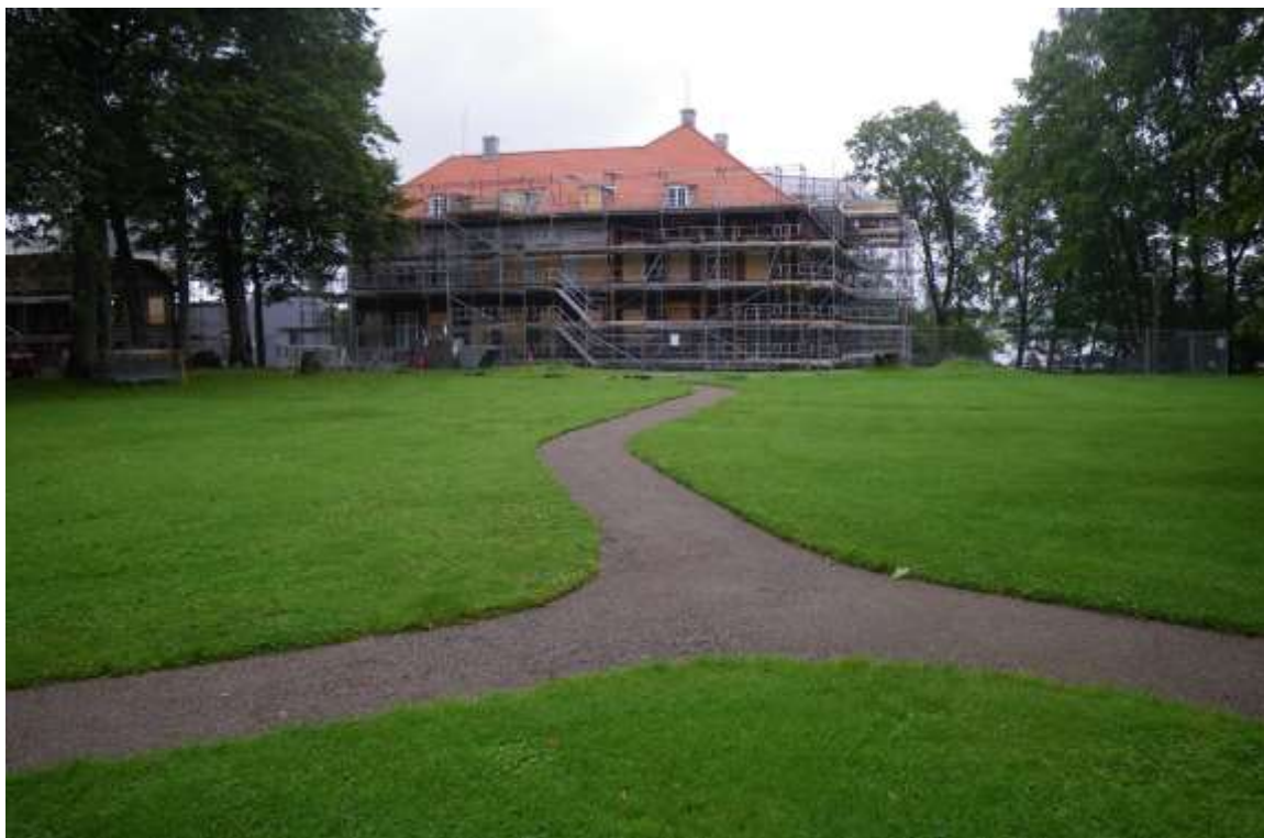
Figur 109. Den centrala delen av Sørparken mot norr. Det nya gruslagret har kommit på plats i de renoverade gångarna. Foto: 120806AA.
