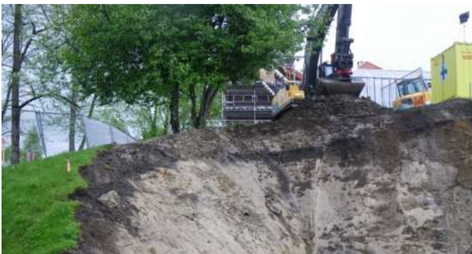
Figur 174. Schaktet för Ventilationstornet mot nordöst och öst. Notera särskilt lager mellan gräsyta och ljus lerig undergrund. Foto: 130527AA.
