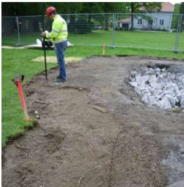
Figur 23. inmätning av gruslager i "nischen" mot öst där en av bänkarna stått. I mitten en närbild av det grova naturgruset som låg direkt under duk. Nederst till höger syns en träbit i kanten av gruset på monumentets nordöstra sida, oklart om den kan ha haft någon betydelse. Foto: 120606.
