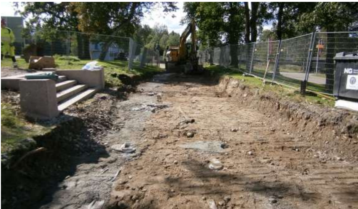
Figur 18. Schaktning av infartsvägen/åtkomsten mot väst. Till höger trappan till Ankermonumentet. I botten av schaktet syns det moderna gruslagret, som inte gått igenom, och en modern dränering. Foto: 130819AA
