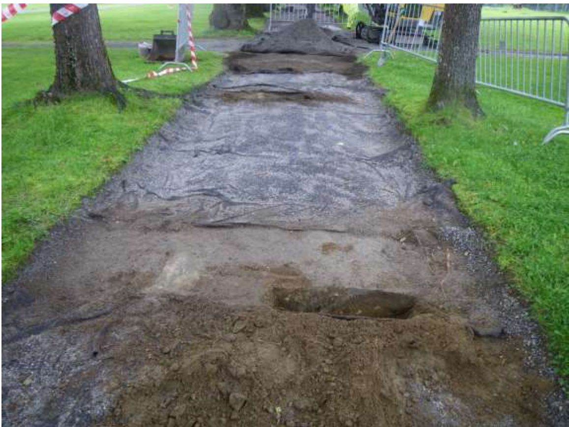
Figur 79. I förgrunden den lerstråksdel som mätts in som "Leire 12" samt Provrop 13 till höger, inmätt som "Test 12". Foto: 120618AA. Jämför även Figur 75, där samma yta syns rensad men inte grävd.
