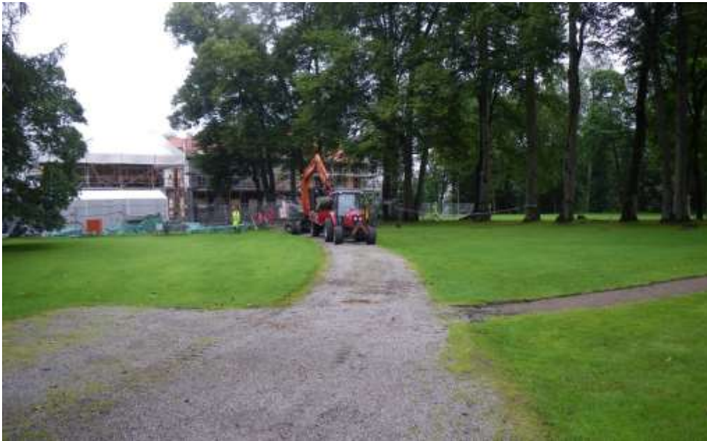
Figur 57. P-ytan till vänster, gången mellan Søndre paviljongen och konservatorboligen rakt fram, och gången till Sørparkens centrala del till höger, fotograferat mot nordöst. Borttagningen av det översta gruslagret ner till markduk har precis börjat. I. SFoto: 120806.
