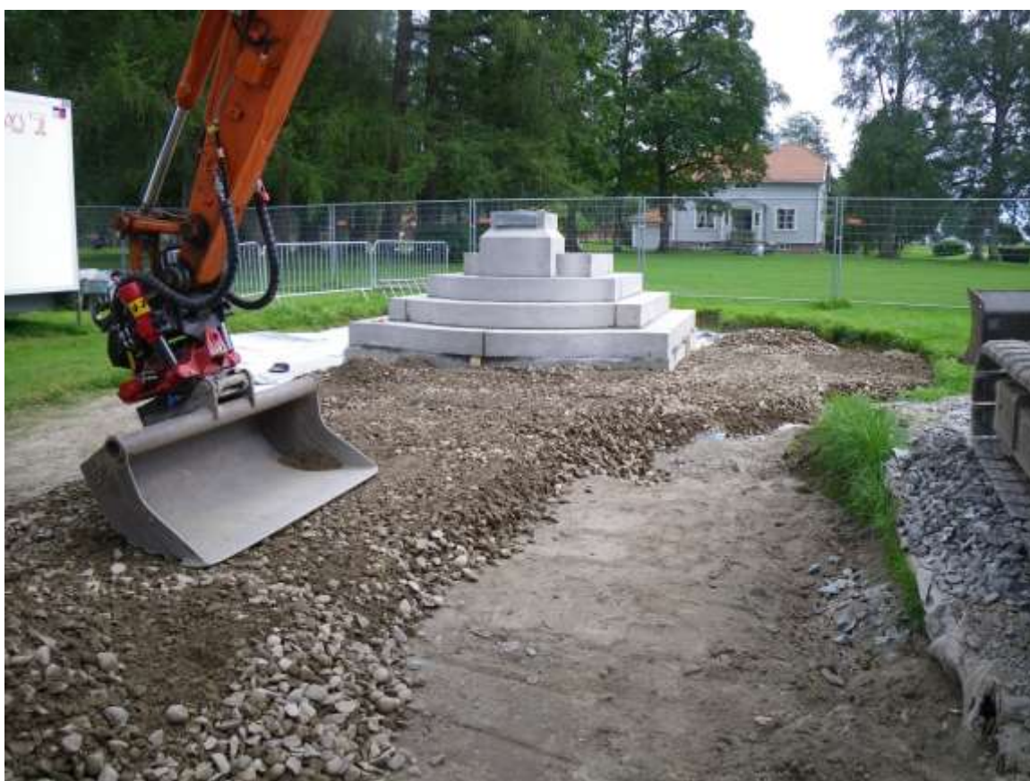
Figur 46. Det nya nedersta grundläggande lagret för gång och grusyta vid Ankermonumentet läggs på plats. I bakgrunden syns konservatorboligen. Foto: 120816AA.
