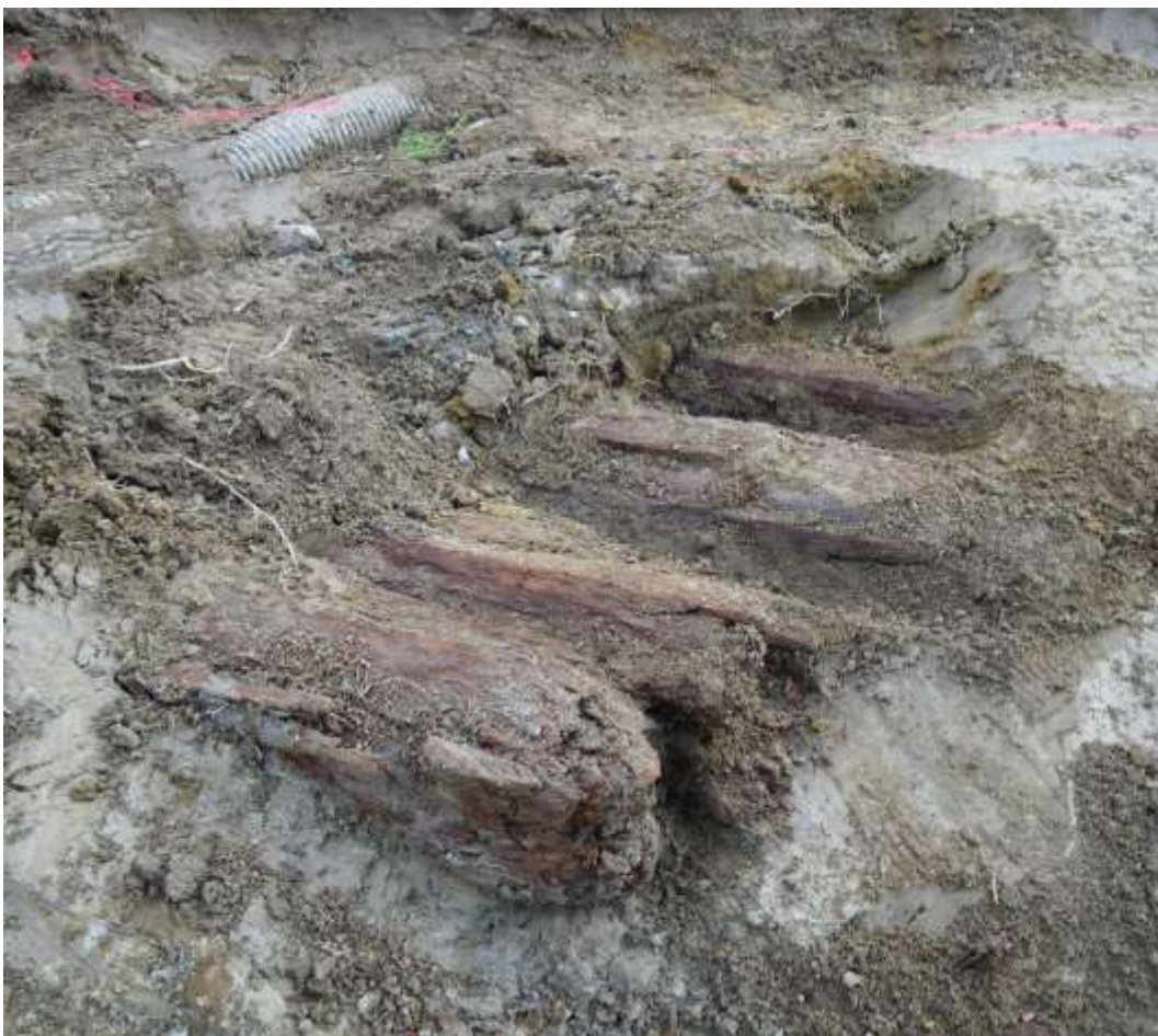
Figur 41. Tätt placerade stockar (Tre/Tre A) och eventuell syllsten (Stein, Stein A) framkomna strax sydöst om Ankermonumentet. Den översta bilden taget mot syd/sydväst. Nederst har stenen tagits bort. Stockarna ser ut att ha grävts av då gropen för Ankermonumentets betongfundament grävdes, till vänster om stockarna i bild. Fotografiet taget mot söder. Foto: 120607AA.
