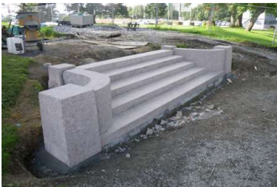
Figur 47. Överst syns det frilagda betongfundamentet för trappan, fotograferat mot öster och Tunet där det stora grå tältet stod då bilden togs. Fundamentet reparerades där det spruckit i östra delen, men användes förövrigt som det var. Foto: 120614AA. Bilden i mitten är tagen mot sydväst. Foto 120807AA. Bilden längst ner visar den restaurerade trappan mot väst. I bakgrunden skymtar parkeringen. Foto: 120814AA.
