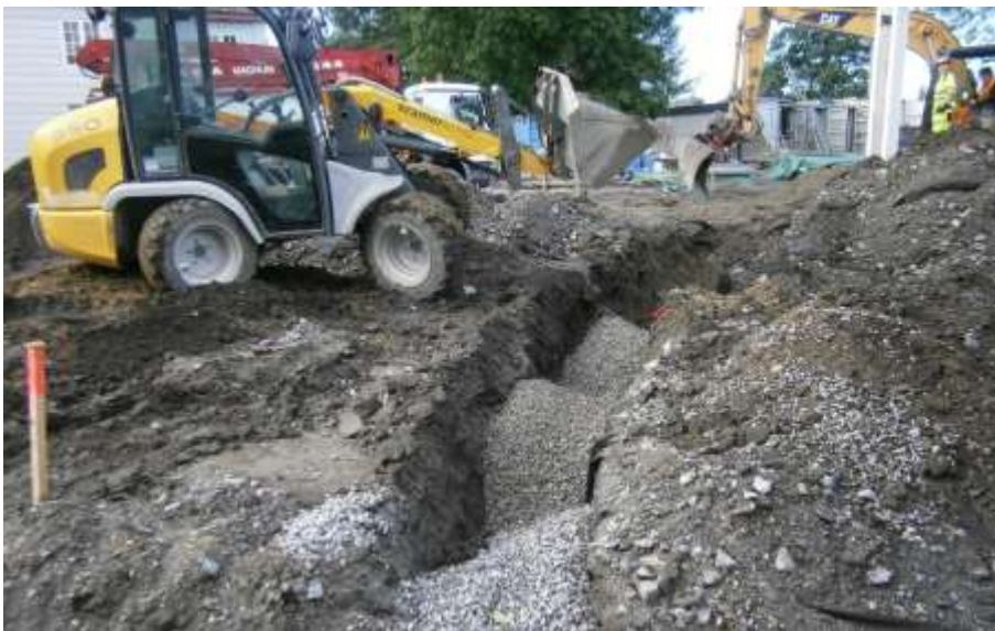
Figur 16. Det smala schaktet för el-ledningen fortsatte in mot gräsrundelns centrala del och flaggstängen. Här håller det redan på att fyllas igen, med dränerande massor. Foto: 130819AA.
