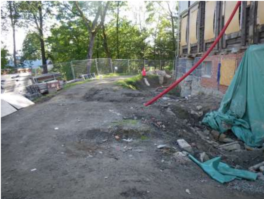
Figur 179. Området Kjellerinngangen norr om huvudbyggnaden, fotograferat mot öst i augusti 2012. Foto: 120816AA.
