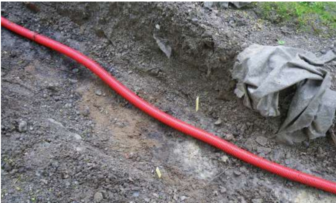
Figur 230. Nedre kanten av sluttningen, på bilden syns övergången från slagg, till ett grusigare lager med inslag av slagg, till vit undergrundslera. Övergången är på bilderna markerad med två trämarkörer. Foto: 120538AA.
