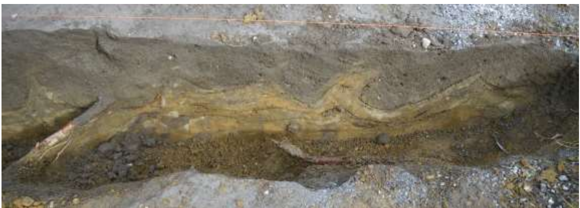
Figur 120. Närbilder av Sektion 21, från väst till öst, som visar bland annat gropigheten och melleringen hos de underliggande lagren (Sektion 21 lager 2, 3, 4 och 5). Foto: 120810AA.
