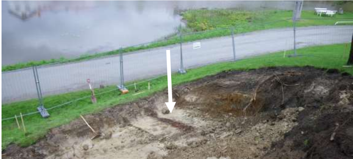
Figur 171. Gropen för Ventilationstornet mot norr. Pilen visar resterna efter en äldre dränering, i form av en ihålig stock, som kunde följas uppåt i slutningen mot söder (se följande bilder). Foto: 130523AA.
