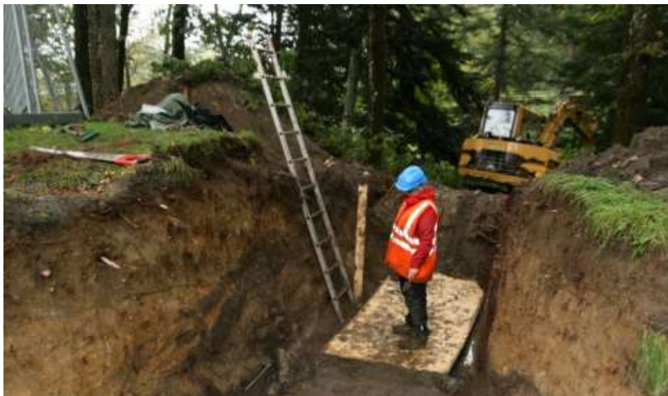
Figur 145. Arbetet i schaktet blev tidvis lite krångligt eftersom vädret var regnigt och en del av schaktet snabbt blev lerigt och fullt av vatten. Med stegar och en skiva över det blötaste partiet gick det dock bra. På bilden Anna Andréasson. Foto mot öst. Foto 120926 Ingeborg Mellgren Mathiesen.
