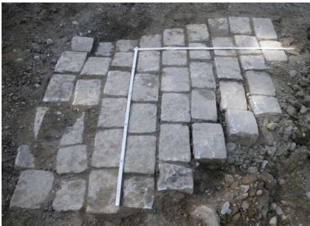
Figur 223. Parti med storgatsten i norra delen av Østparken, mot väst. Foto: 130604AA:
