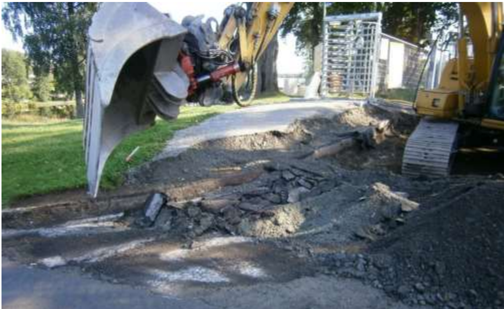
Figur 21. Den sista biten mot Carsten Ankers väg. Asfalten på väg att grävas bort. Intill asfalten syns en rundad kant av huggen granit. Foto: 130820AA
