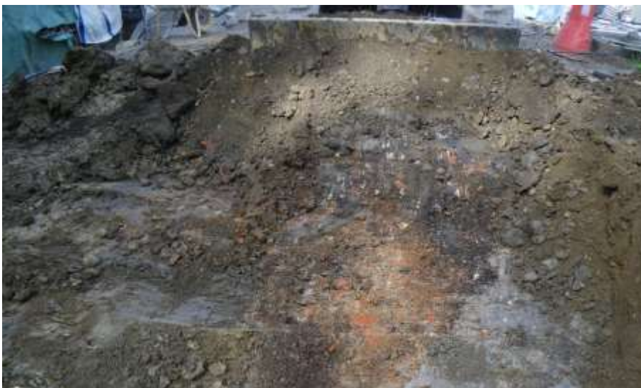
Figur 181. Schaktning längs huvudbyggandens fasad mot norr. Öster om betongbrunnen och en bit ut från fasaden fanns lager blandade med bränt byggnadsmaterial och en del fynd av äldre (1700-tals) karaktär. Foto: 130618AA.
