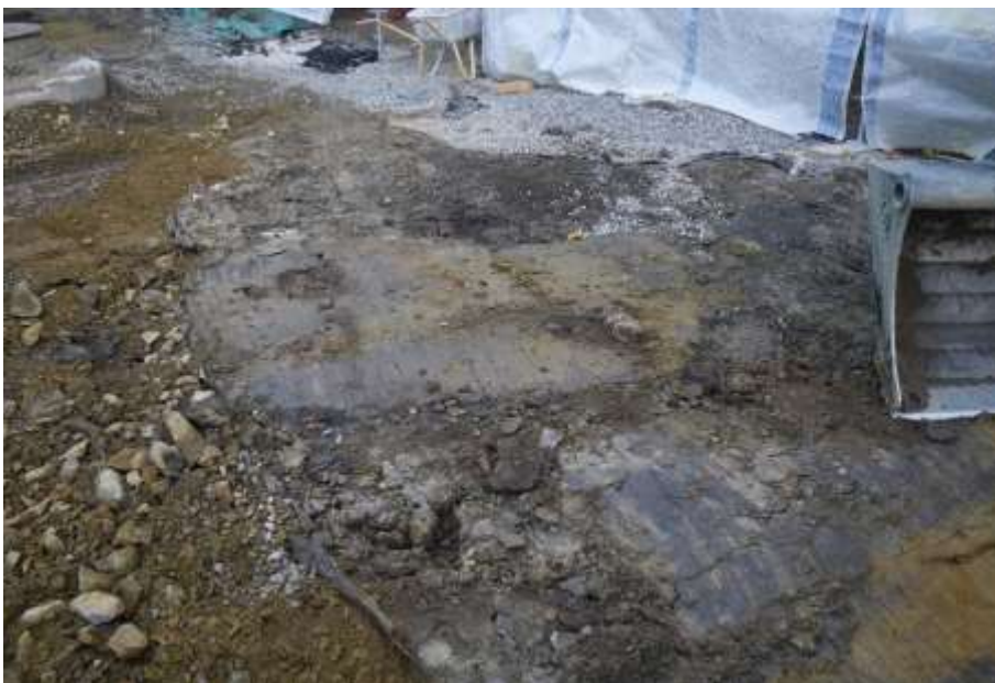
Figur 182. Schaktning längs huvudbyggnadens fasad mot norr, väster om brunnen fanns enbart material som såg ut att vara omrört under senare tid. Foto: 130619AA.
