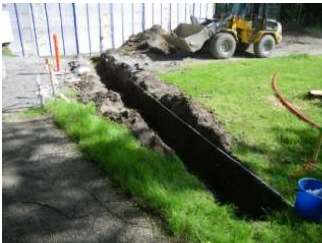
Figur 110. Schakt för elledning till fasadbelysningsstolpe mot N. Foto: 130619AA.
