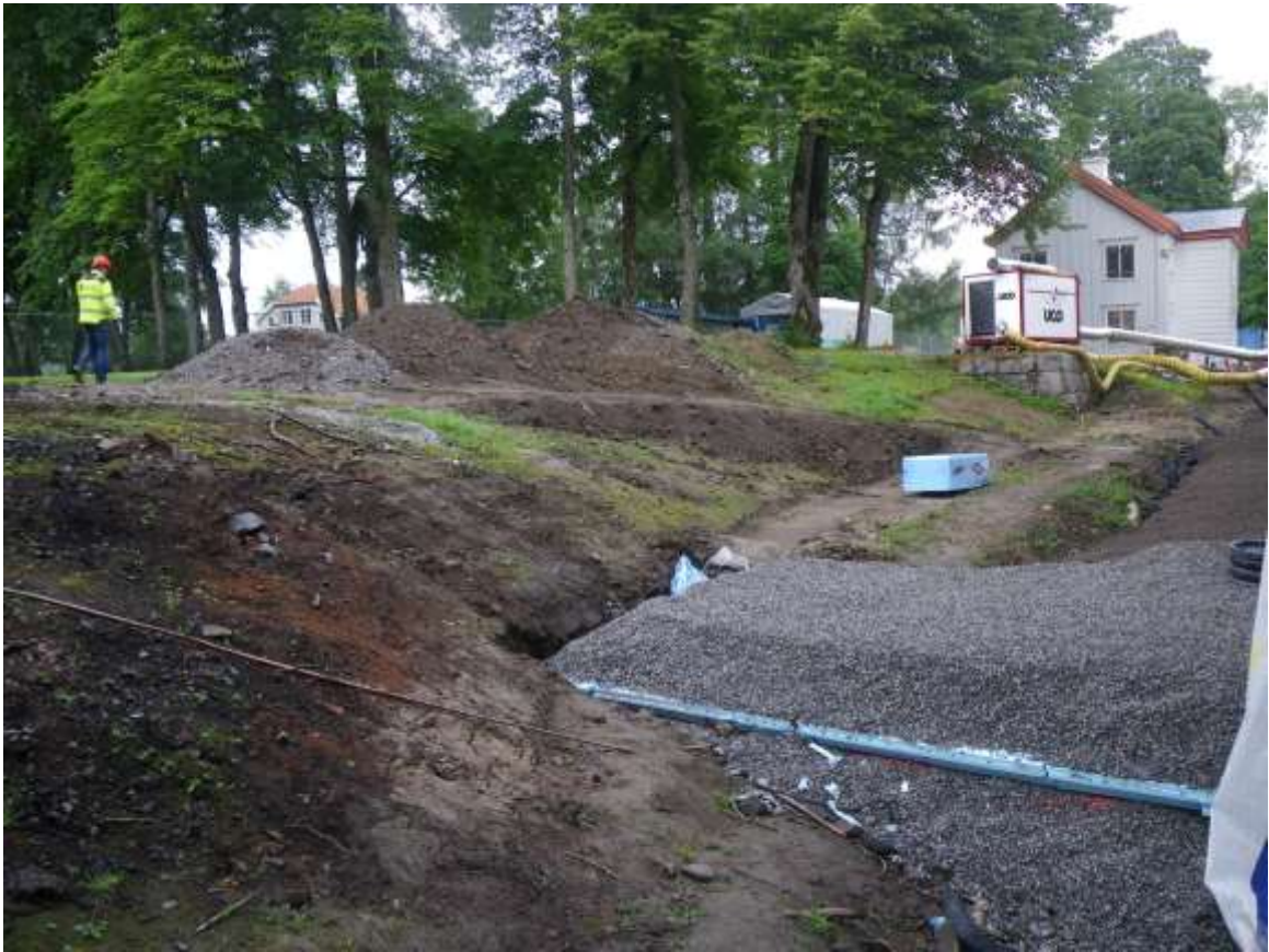
Figur 243. Ytan söder om huvudbyggnaden. Det brända slagglagret mellan Sørparken och Østparken syns till höger och fundamentet till den nya trappan ut från biblioteket. Foto: 130805AA.
