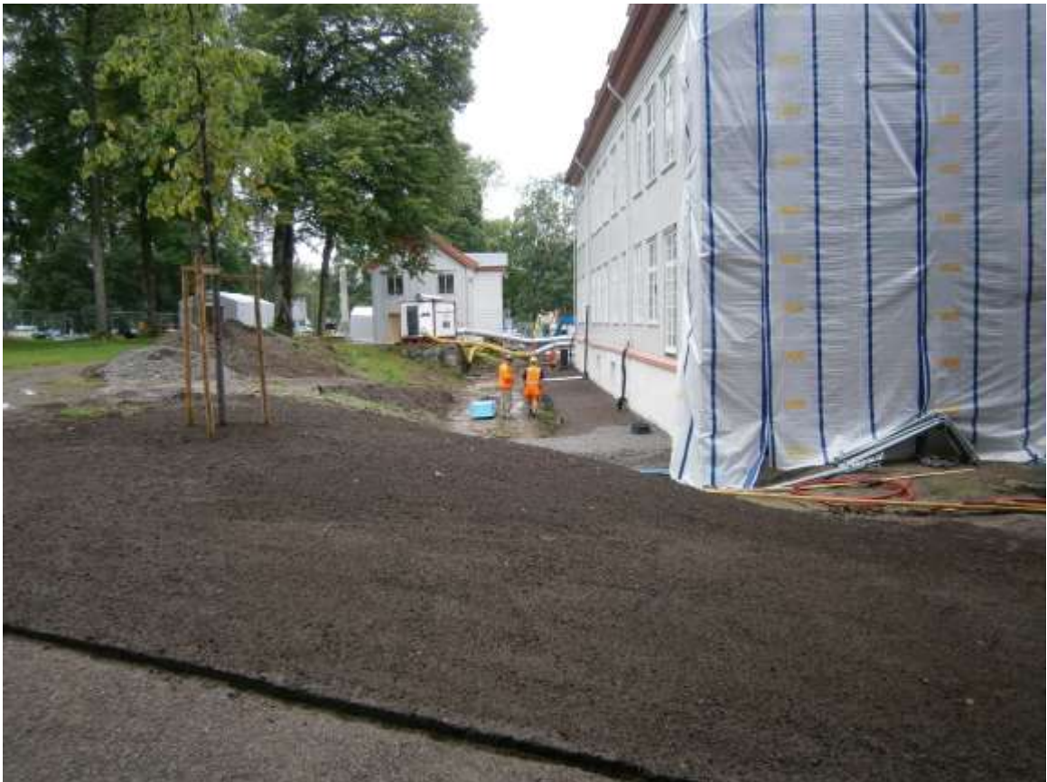
Figur 244. Slänten mellan Sørparken och Østparken efter att det nya matjordslagret lagts på. Den gamla stubben har frästs bort och ersatts med ett nytt träd som syns till höger. Foto: 130807AA.
