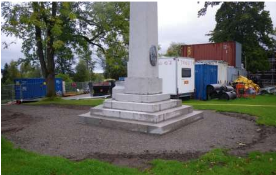
Figur 48. Ankermonumentet efter restaurering, överst mot söder och nederst mot nordöst. På bilderna syns det första grundläggande gruslagret som lagts ut, det övre saknas fortfarande. Foto: 120919AA.
