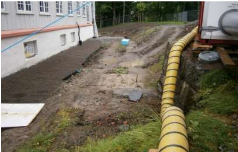
Figur 165. Ytan direkt söder om huvudbyggnaden i början av augusti 2013. Intill grunden syns den färdiga dräneringen fylld med leca, längst bort syns grundläggningen till trappan från biblioteket. Foto: 130807AA.
