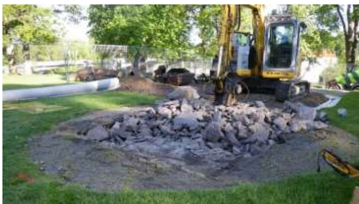
Figur 22. Övre bilden visar betongkärnan i monumentet efter att de huggna granitstenarna tagits bort. Bilden i mitten visar det kraftiga betongfundamentet som monumentet stod på. Nedre bilden visar hur fundamentet börjat tas bort. Det visade sig att betongfundamentet var betydligt djupare och bastantare än någon kunnat tro. Det visade sig omöjligt och onödigt att ta bort hela. Den allra nedersta delen av betongfundamentet finns alltså fortfarande kvar under den moderna grundläggningen. Foto: 120604AA.
