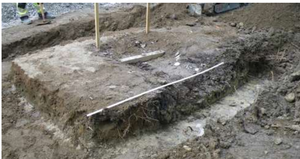
Figur 206. Det södra och det östra schaktet mot nordväst. Foto: 130529AA.
