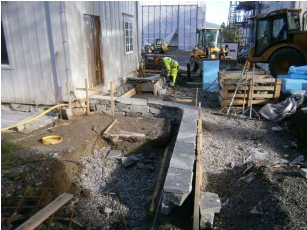
Figur 50. Braathen landskapsentreprenør AS arbetar med den nya handikappanpassade entrén till Søndre paviljong och utformning av ytorna kring denna. Foto: 130810AA.
