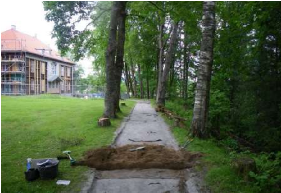
Figur 96. Norra delen av Østre allé mot norr, i förgrunden Sektion 19. Foto: 120620.
