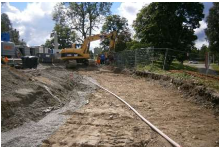
Figur 13. Schaktning på norra sidan mot väster. Det moderna gruslagret och den ännu modernare dräneringen syns i schaktets botten. Foto: 130813AA.
