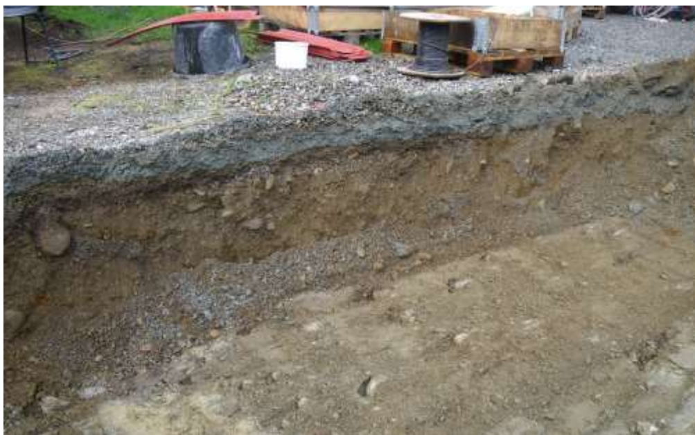
Figur 11. I kanten mot söder syns det moderna gruslagret och över detta det ännu yngre lagret av grått krossgrus. Inom den yta intill södra paviljongen där det moderna gruslagret grävdes bort visade det sig vara ca 60 cm tjockt. Under gruset fanns här en ljus undergrundslera. Foto: 130806AA.
