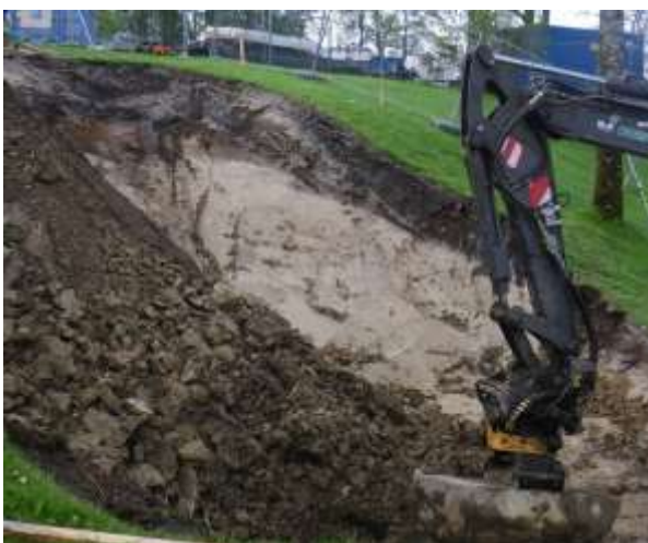
Figur 176. Schaktet för Ventilationstornet mot sydväst. Notera särskilt lager mellan gräsyta och ljus lerig undergrund. Foto: 130524AA.
