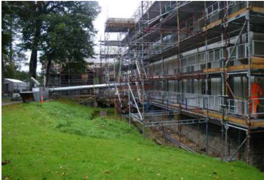
Figur 161. Området närmast huvudbyggnadens sydfasad mot väster. Foto: 120919AA.
