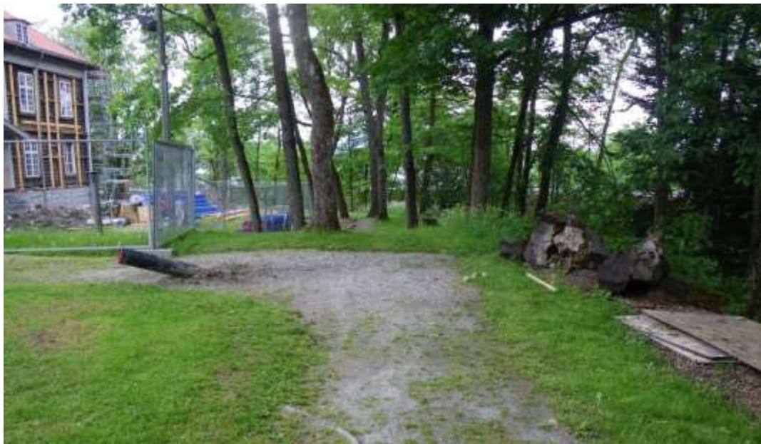
Figur 133. Området i nordväst delen av Sørparken fotograferat mot norr innan schaktningen startade. Det svarta röret som sticker upp till vänster skulle grävas fram för att sedan kopplas till andra vattenrör. Foto: 120613AA.
