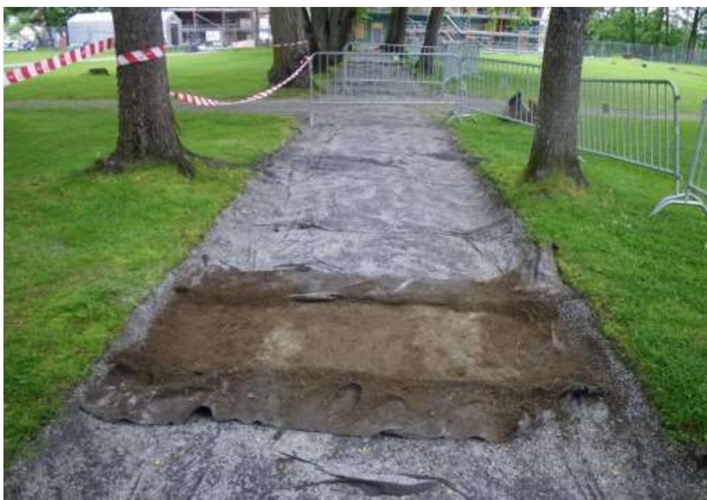
Figur 75. Södra delen av Vestre allé. Redan vid den första rensningen av en del av ytan under duken syntes ljusa skiftningar i den centrala delen av gången som också var något upphöjd. Foto: 120614 AA
