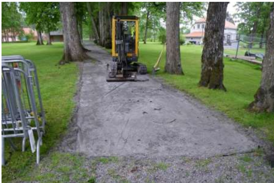
Figur 66. Den västra allégången mot söder. Det överliggande moderna gruslagret håller på att schaktas bort ner till markduken som ligger under. Foto: 120613AA.
