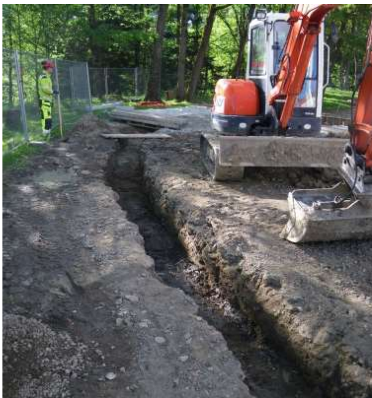
Figur 216. Fortsatt grävning av dräneringsschakt i norra delen av Østparken, mot öst. Foto: 130604AA.
