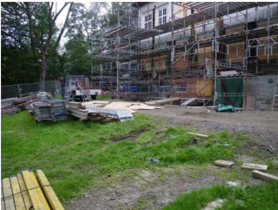
Figur 178. Området Kjellerinngangen norr om hovedbyggnaden, fotograferat mot sydöst i augusti 2012. Foto: 120813AA.
