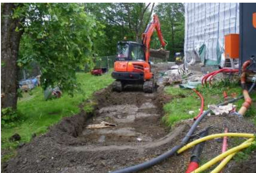
Figur 186. Överst och mitten: vid schaktningen noterades längs i sydöst lager med bränd fyllning som skars av modernare lager. Foto: 130625AA. Nederst: I den nordvästra delen verakde däremot i princip allt vara omgrävt för nedläggning av rör och annat vid senare tidpunkter. Foto: 130626AA
