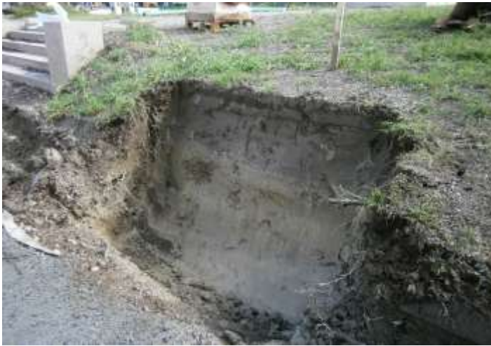
Figur 19. Grop för belysningsstolpe. I schaktväggen mot söder syns det här ca 50 cm tjocka matjordslagret, och under detta den ljusa orangebruna undergrundsleran. Foto: 130819AA.
