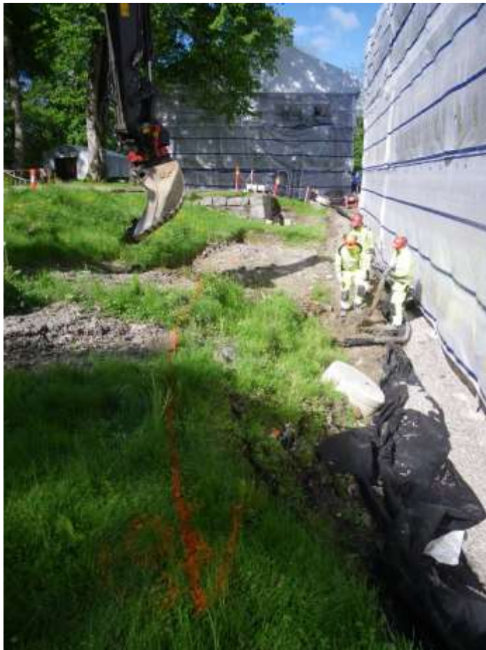
Figur 162. Grävarbetena direkt söder om huvudbyggnadens fasad påbörjades i 4 juni 2013, bilden tagen mot väster. Foto: 130604AA.
