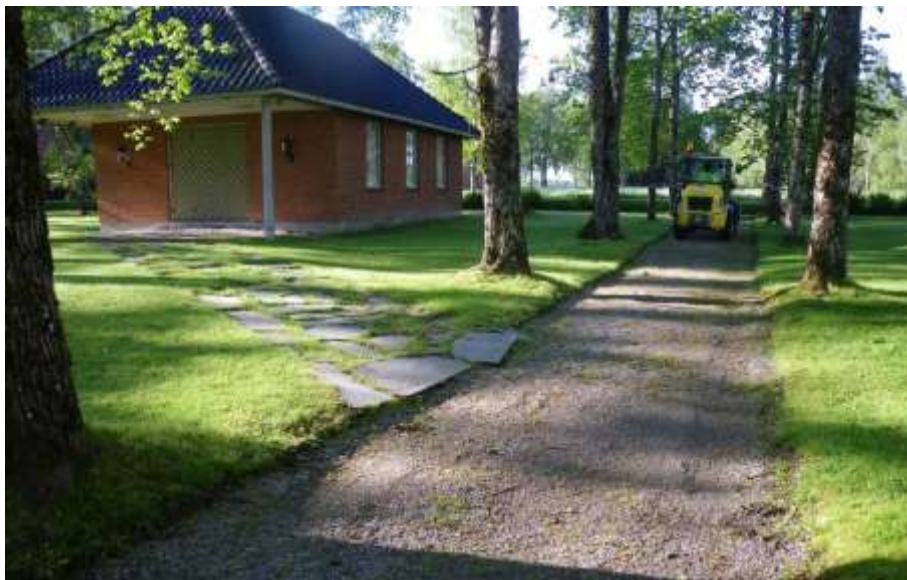
Figur 67. Den sydligaste delen av västra allégången med den stensatta gången till vognremissen till vänster. Det moderna gruslagret är fortfarande kvar. Foto: 120605AA
