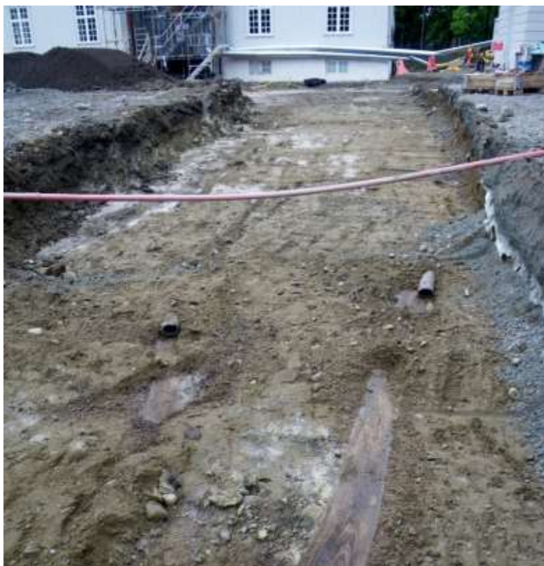
Figur 10. Schaktning för ny vägbeläggning på sydsidan av Tunet mot öst. I förgrunden syns dräneringsrör av plast som ligger på träplankor. Under de kvarvarande moderna grusresterna syns den ljusa undergrundsleran. Foto: 130806AA.
