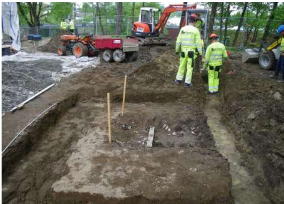
Figur 212. Till höger i bild syns hur det fortsatta dräneringsschaktet mot norr börjat grävas. Foto: 130529AA.
