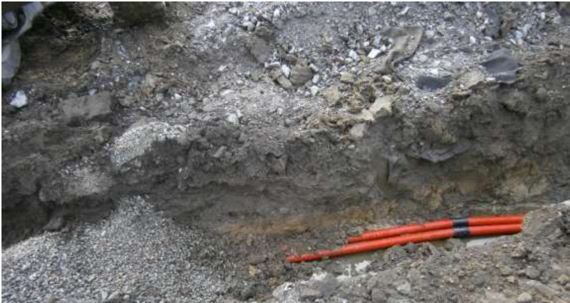
Figur 17. I schaktväggen mot öster syntes att matjordslagret här verkade vara ca 30 cm, maximalt 40 cm, tjockt och låg direkt på ljus orangebrun lera. Foto: 130819AA.
