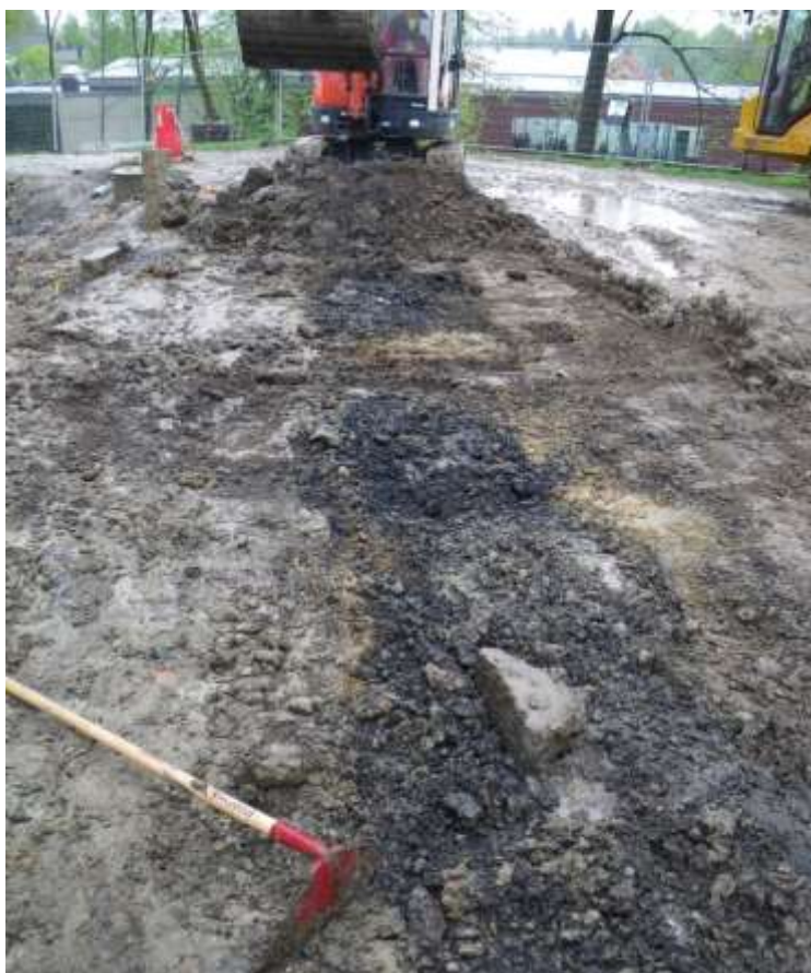
Figur 192. Redan tidigt i schaktningen i den centrala och norra delen av ytan mellan huvudbyggnaden och Ankers grav framkom intill den omrörda ytan närmast husgrunden (till vänster i bilden) tydligt slaggblandade, sotiga och kolblandade lager (till höger i bilden). Slag och kollagren var generellt ganska tunna och diffusa, men inom den centrala delen, direkt mellan huset och Ankers grav, kunde former urskiljas som eventuellt skulle kunna tolkas som någon form av byggnadsspår. Foto: 130522AA.
