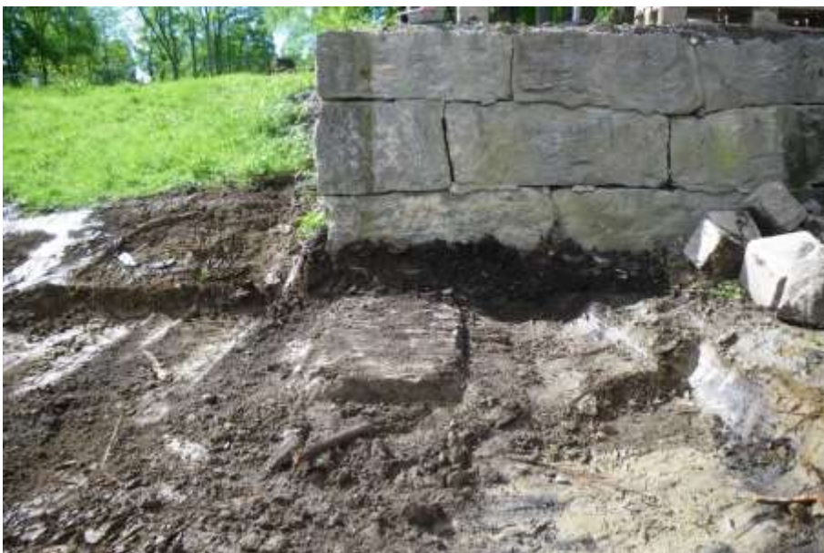
Figur 163. Första schaktningen slänten vid huvudbyggnaden längst mot norr i Sørparken. Överst och mitten Foto: 130606AA, nederst Foto: 130604AA.
