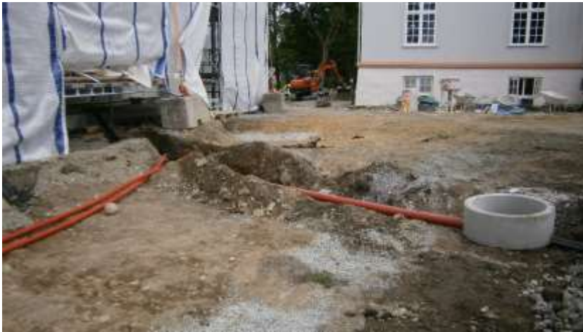
Figur 14. För nedläggning av en el-ledning mellan norra paviljongen och gräsrundelns centrala del grävdes ett smalt schakt lite djupare, genom det moderna gruset. Foto: 130814AA.
