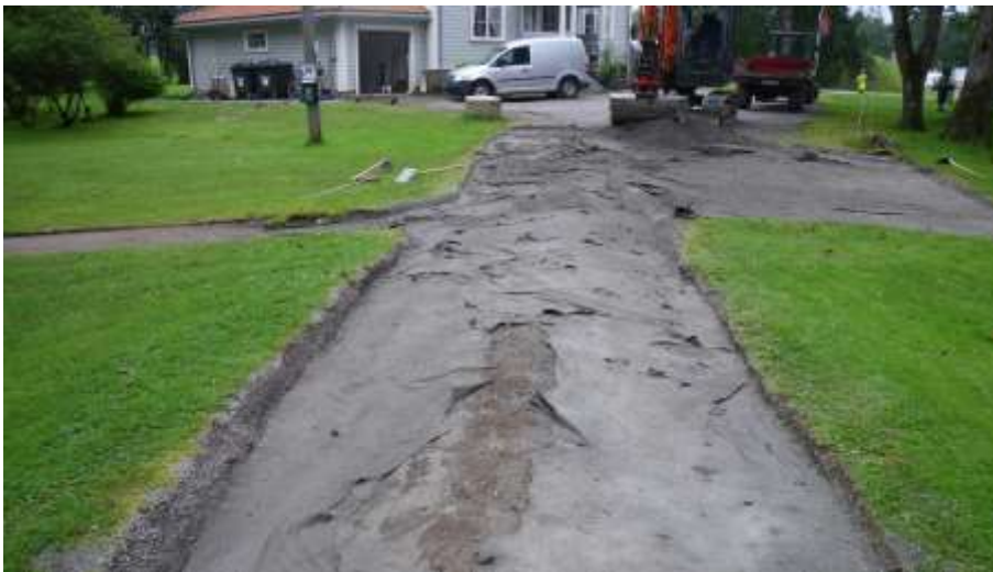
Figur 58. Till vänster syns gången till Sørparkens centrala del och till höger parkeringsytan vid konservatorboligen. Det övre moderna gruslagret har tagits bort ner till markduken. Bilden visar även de tydliga hjulspåren och hur marken tryckts upp i mitten av gången. Mot sydväst. Foto: 120806AA.
