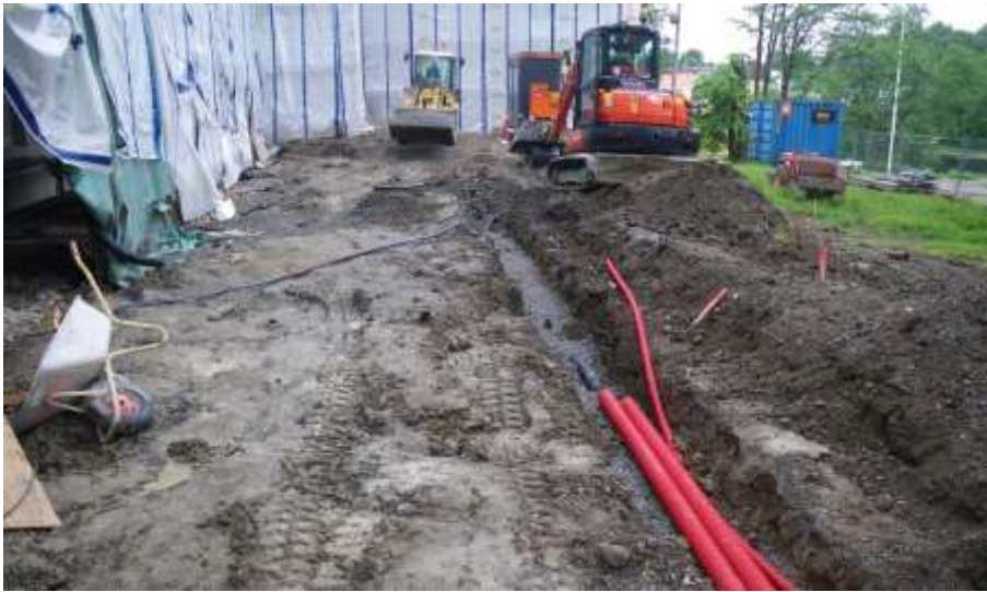
Figur 184. Smalt schakt för dränering norr om huvudbyggnaden. Foto: 130624AA.
