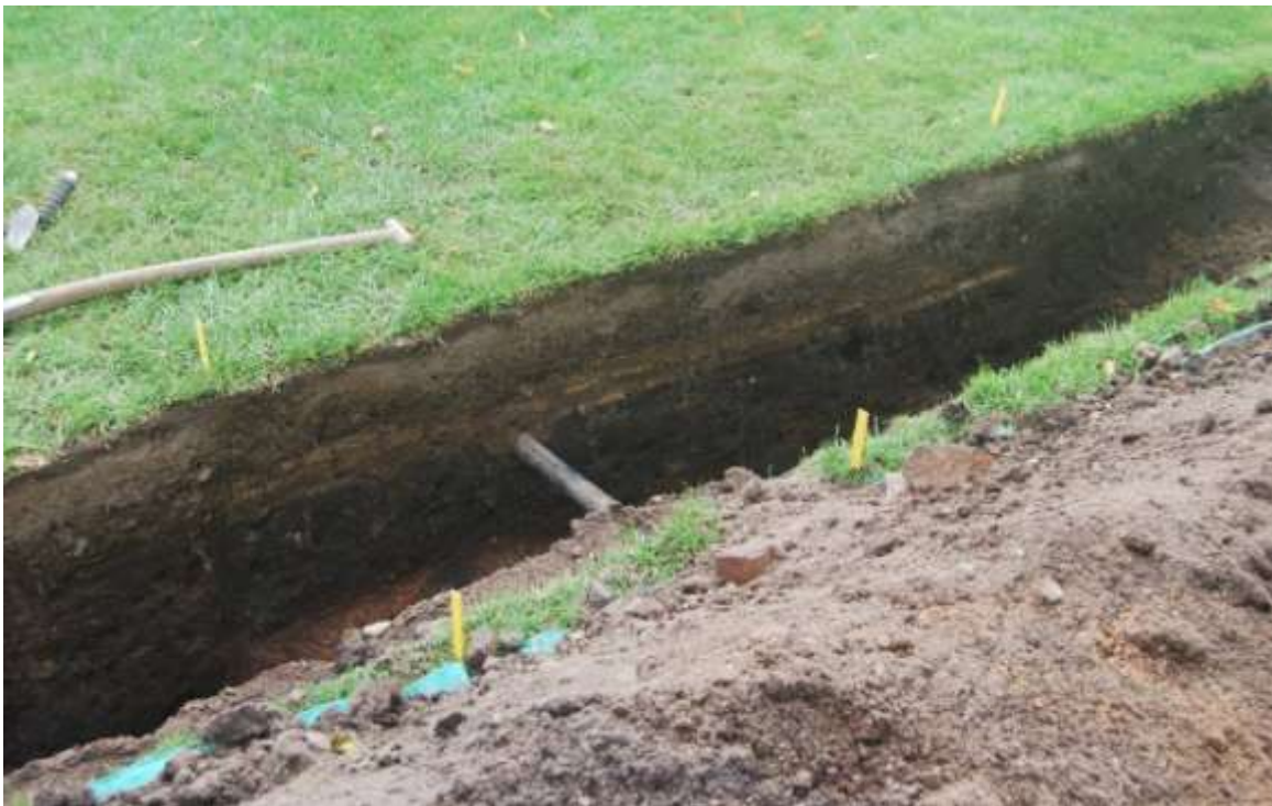
Figur 22. Schakt 5 sektion från NV, foto 080821. Gångens sandlager syns tydligt, skurna av stora rörschaktet till vänster och lilla rörschaktet i mitten. Under gånglämningen fanns i stort sett samma blandade trädgårdsmylla som på sidorna.
