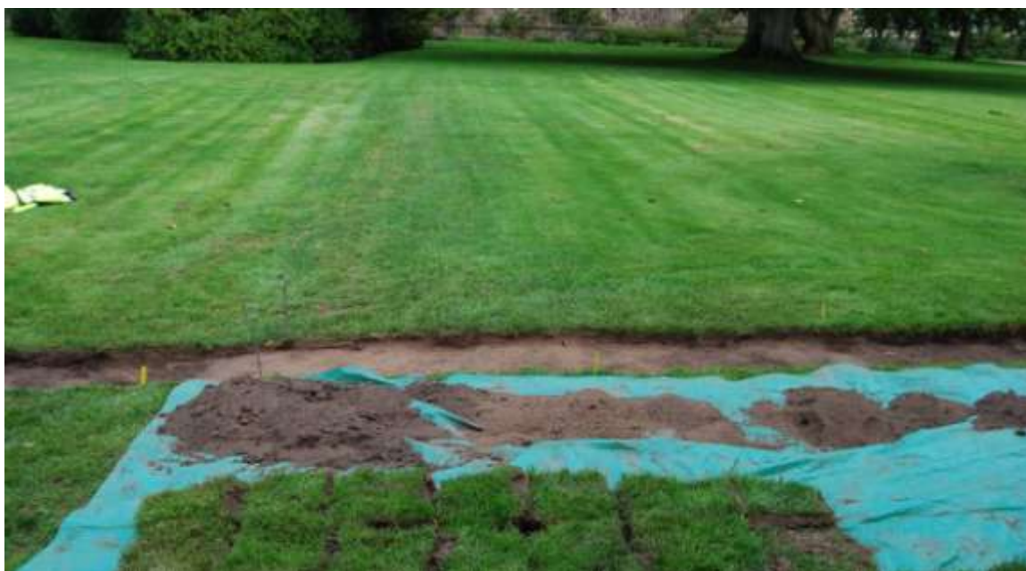
Figur 20. Schakt 5, från väst, foto 080819. Efter avtorvning och första upprensning noteras att fyllningen längs den långsträcktta upphöjningen, som antogs visa gångens sträckning, var tydligt mer torr och kompakt.
