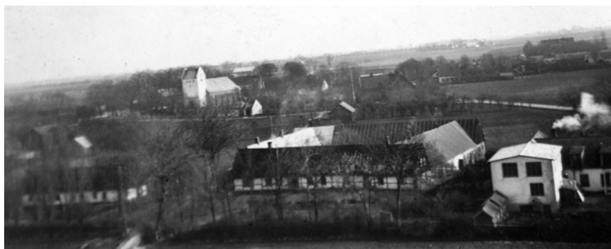
Figur 9. En bild från kvarnen, troligen från sent 30-tal. 16 Trädgårdens former är raka och vinkelräta. Från kyrkstigen till huset löper en rak gång. Till höger syns Orvar Berggrens snickerifabrik och framför fabriken två små hus för bin.
