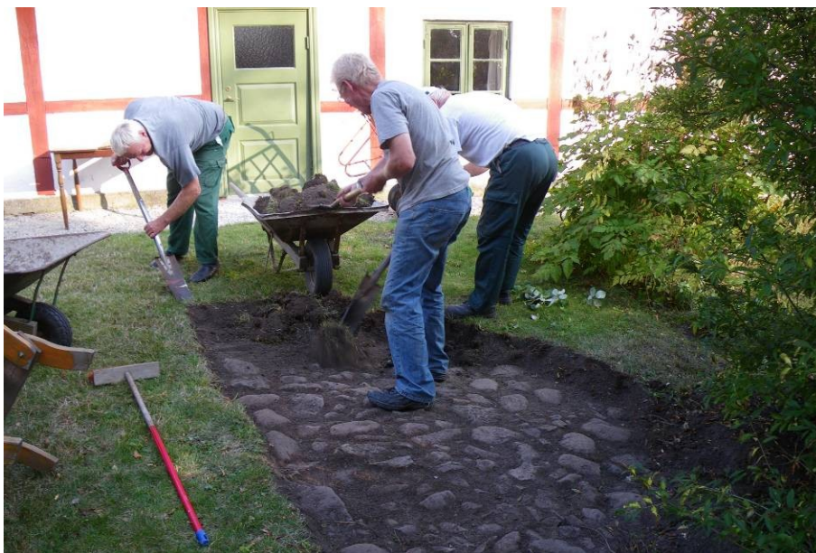
Figur 32. Stenläggningen låg ungefär en decimeter under gräsytan. Foto: 090920.
