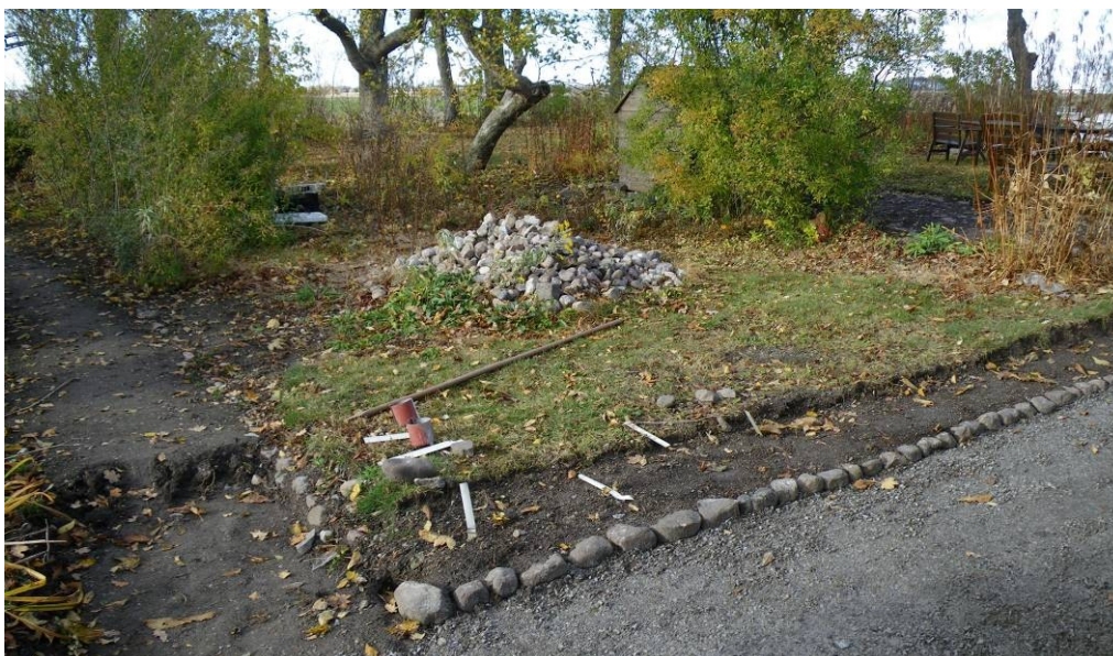
Figur 30. Kanter framgrävda och renoverade. Stenhögen i mitten kommer från kanten längs husväggen, som är på väg att rekonstrueras. Till höger bakom rabatten med plymspirea skymtar brunnshus och stenläggning. Foto: 091029.
