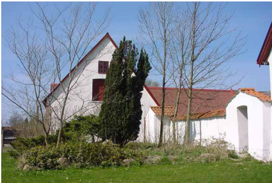
Figur 26. 'Hannas stenbergs' från öster. I anslutning till detta fanns under 1900-talets andra hälft ganska omfattande nyttoodlingar. Trappan från den lilla porten från gårdsplanen, till höger i bild, utgörs av en utsliten kvarnsten. Foto: Andréasson, 050421.
