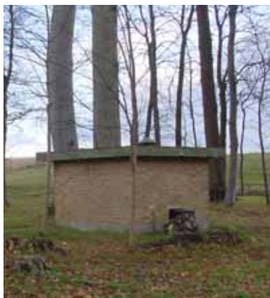
Figur 9. Till vänster ett av pumphusen i parkens södra del. Till höger vattenreservoar m.m. i parkens norra del. Foto: Anna Andréasson 2004.
