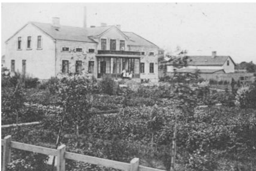
Figur 30. Del av vykort som visar hotellet i Klagshamn från sydväst. Växtligheten i förgrunden är sannolikt handelsträdgården. Fotografiet är troligen taget ca 1910. Foto: Kvarndala Kulturhistoriska Förening.
