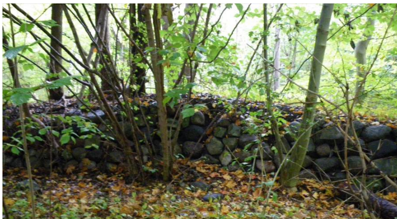
Figur 43. Stenpartiernas insidor är branta med synlig kallmur. Deras yttre sidor är mjukt sluttande och täckta av jord och växtlighet. Foto: Anna Andréasson 101020.
