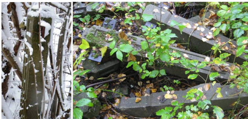
Figur 52. Delområde 6. Till höger betongstolpe i trädgårdens norra kant. Till vänster borttagna staketstolpar i betong med geometrisk dekor, slängda i en hög vid gränsen mellan delområde 5 och 6. Foto: Anna Andréasson, t.v. 101217, t.h. 101020.
