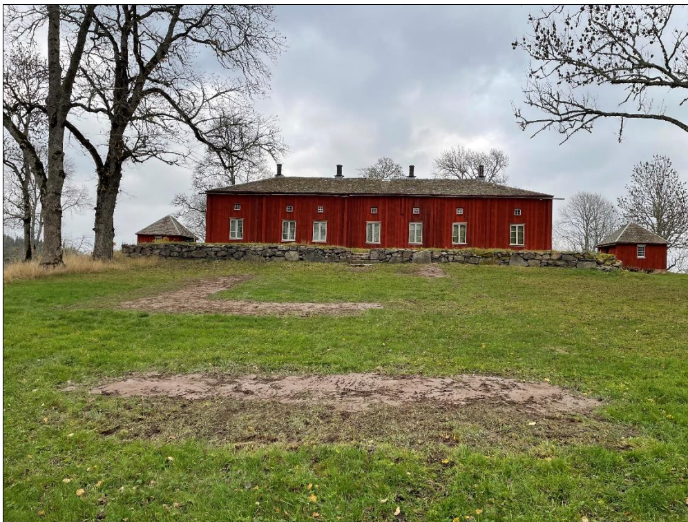
Yta 3 efter återställande av schakt 10–14. Foto från sydväst.
