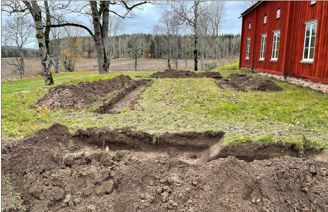
Figur 14. Foto från sydväst som visar omfattningen av schakten som grävdes i yta 2, parterrdelen av trädgården.
