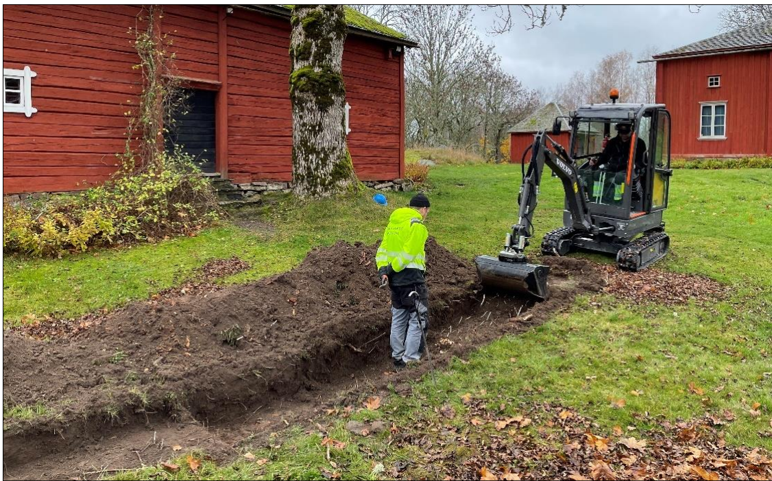
Figur 6. Foto som visar maskinunderstödd grävning av Schakt 1 i övre gårdsplanens sydöstra del hösten 2021. Foto från nordost.
